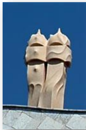
Casa Milà Schoorsteen
